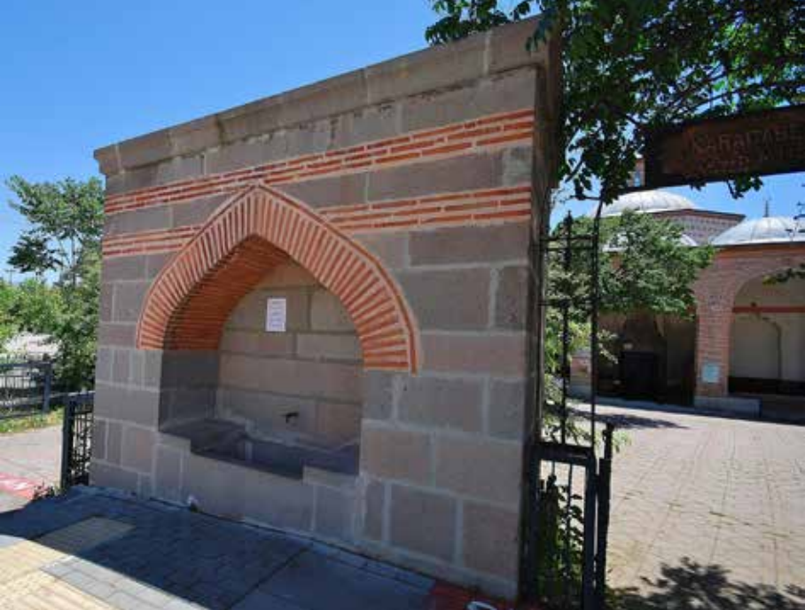
Karacabey Çeşmesi'nin restorasyon sonrası durumu (Fotoğraf: Yavuz İşçen, 2016).
